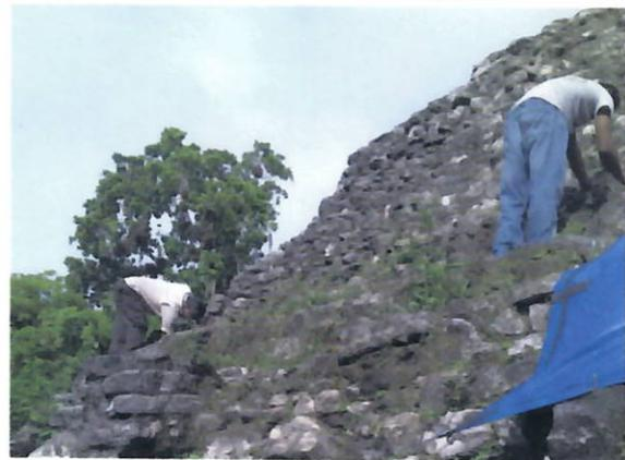
**Fig. 2. Limpieza en mampostería y capas de sacrificio del edificio 152 de la Plaza “C” del Sitio Arqueológico Yaxha.**
