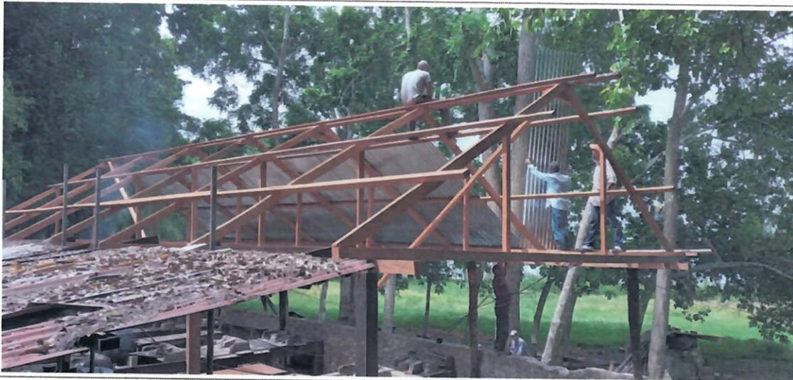
Fig. 5. Armado de estructura e instalación de lámina acanalada en cocina de los colaboradores del PNYNN.
